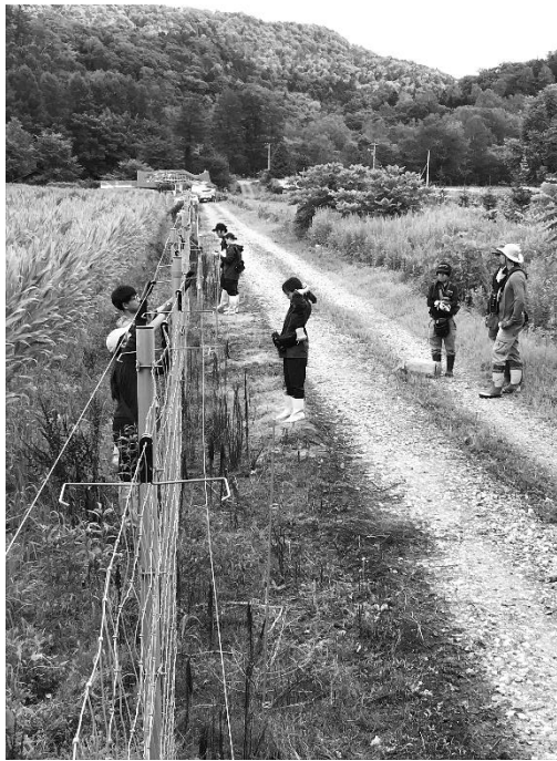
試験電気柵の設置作業風景(8/2)
